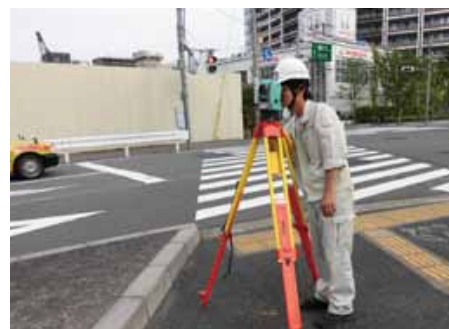
トータルステーションによる測量風景
