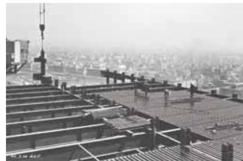
建設中の風景
